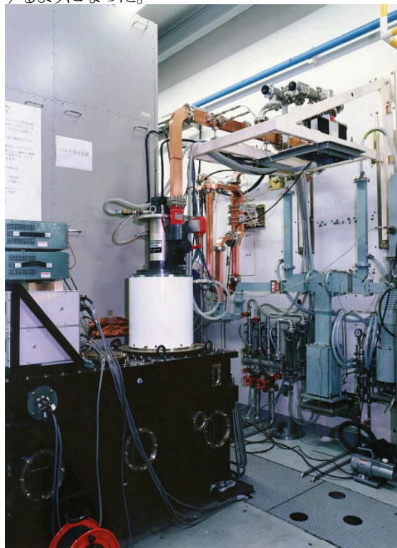
写真5 改良前のクライストロン出力窓周辺と立体回路。
