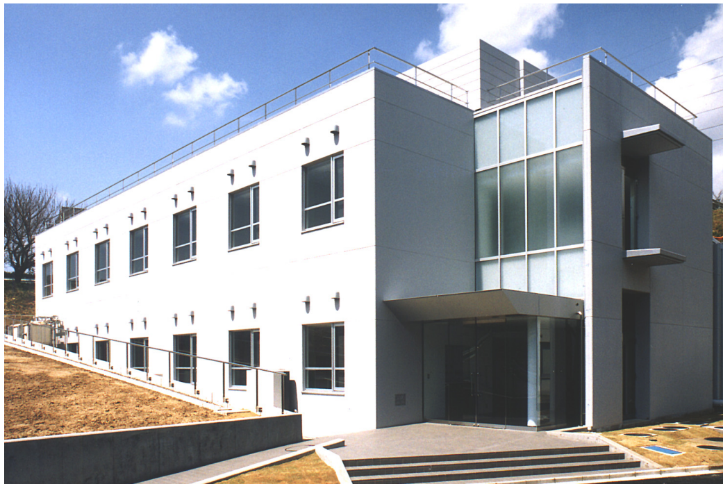
写真1 学術フロンティア推進事業によって増築した新実験棟
